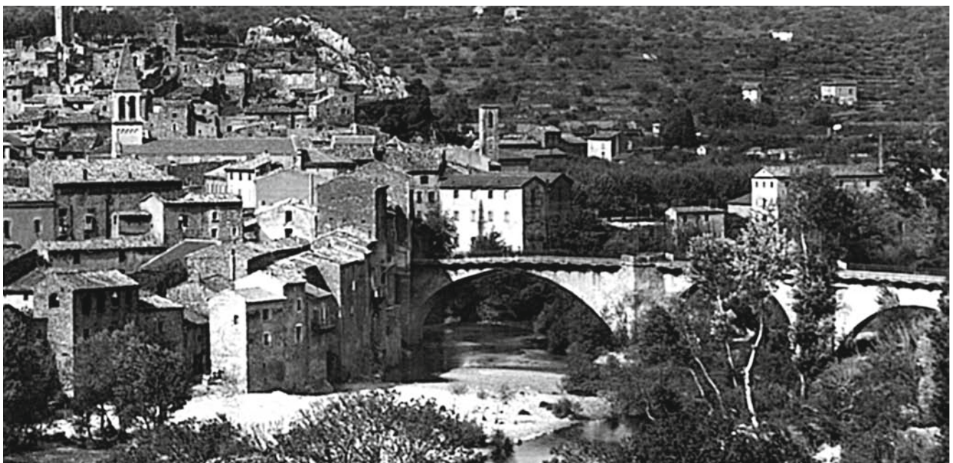
La crue a atteint le sommet des arches.
