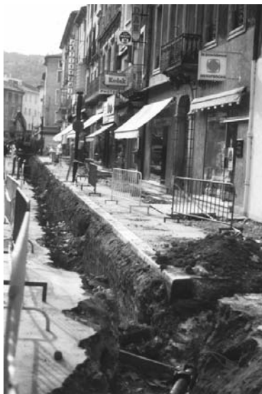
Saint-Ambroix 1974 : Travaux le long des remparts visibles sous le trottoir. L'emplacement de la porte du Portalet se situait au niveau de la pelle mécanique
