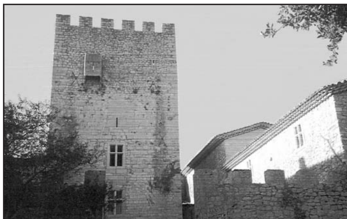
Tour Bermonde et aile nord-est
