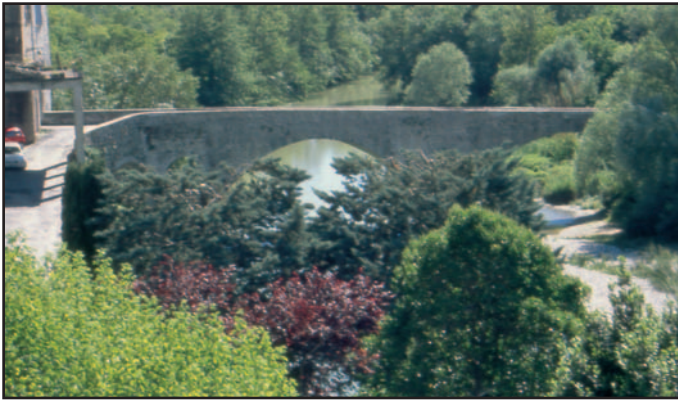
Pont médiéval à Sauve
